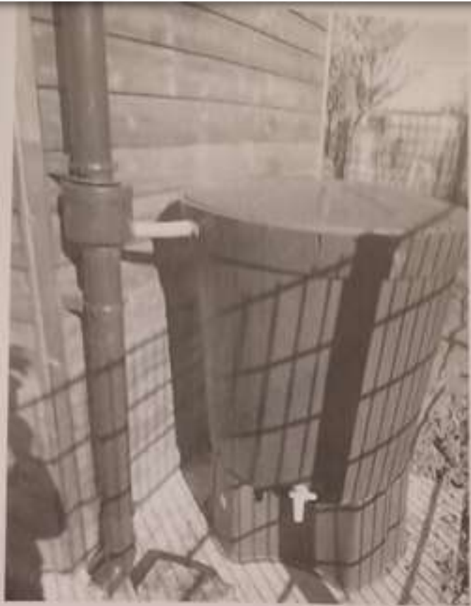
Le récupérateur d'eau de pluie.
