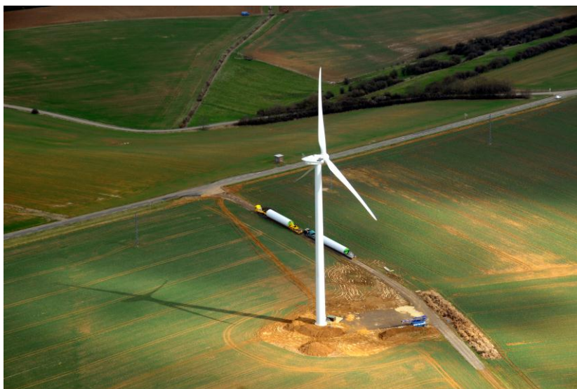
Construction du parc éolien d'Anoux, en Lorraine
