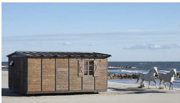
Maison démontable 6x6m 1944 Jean PROUVÉ : ces pavillons d'urgence étaient destinés à reloger les sinistrés de Lorraine. Transportables et démontables, faits en bois et métal, 2 jours à 2 personnes étaient suffisants pour les monter.
