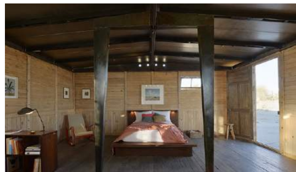
Maison démontable 6x6m 1944 Jean PROUVÉ : ces pavillons d'urgence étaient destinés à reloger les sinistrés de Lorraine. Transportables et démontables, faits en bois et métal, 2 jours à 2 personnes étaient suffisants pour les monter.
